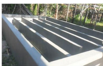
Préfiltre à sable gravitaire installé avant le REEPS pour retenir 98% des matières en suspension.
