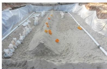
Pose des drains d'aspiration sur le lit de sable dans le fond du REEPS.
