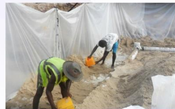
Recouvrement des drains avec du gros sable ou des gravionnettes.
