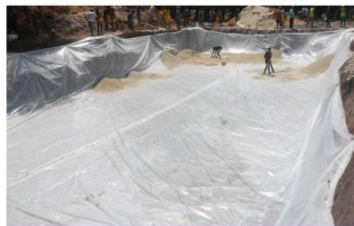
Remplissage du REEPS par du sable après creusement de la fouille 100m 3 et pose de la géomembrane.
