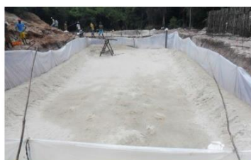
Remplissage du REEPS par le sable et installation du puits.
